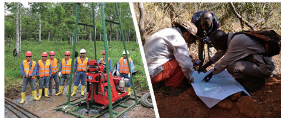
厄瓜多尔德尔西水电站钻孔取芯施工
