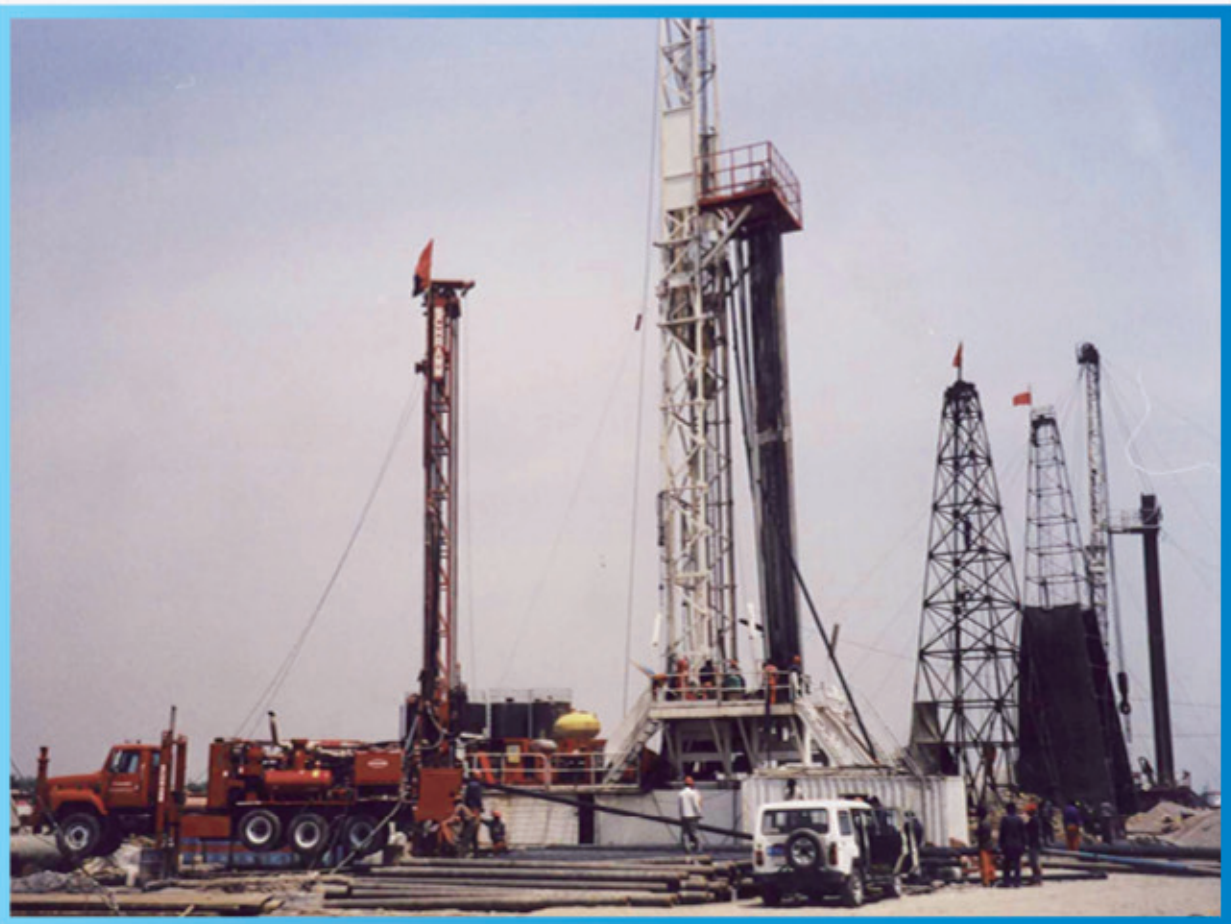
邢台东庞矿抢险
