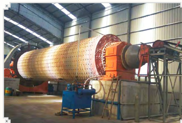
门克庆煤矿 3101 工作面采动覆岩离层区注浆工程
