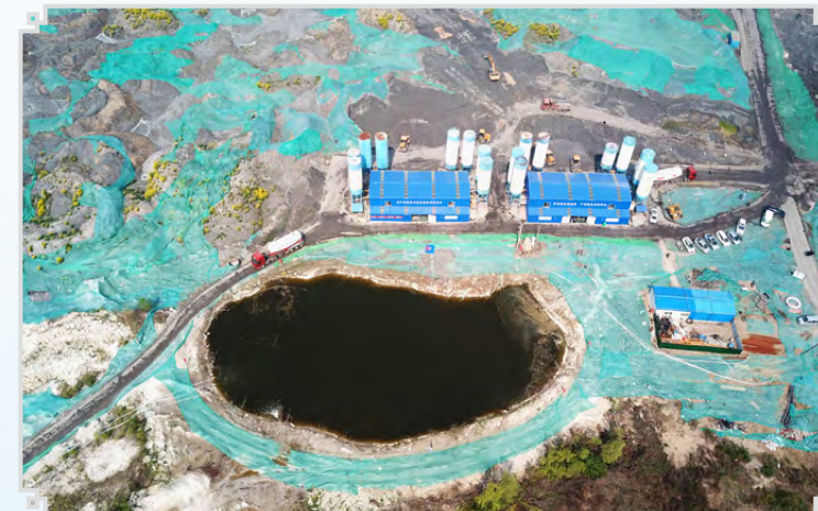
江苏省连云港新浦磷矿沉陷区治理项目现场
