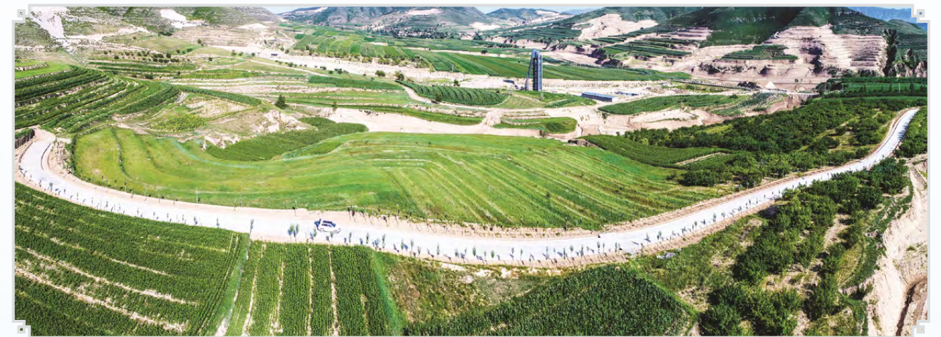
山西一斗泉土地整治项目现场
