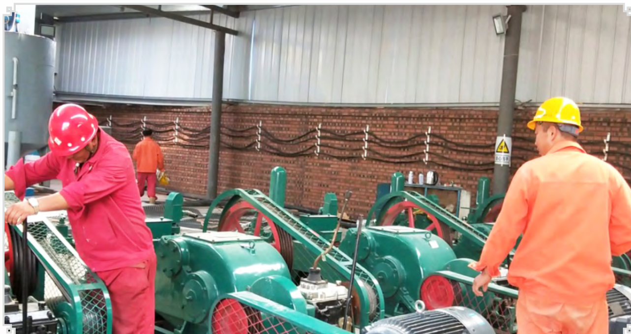
夏店离层注浆项目标准化工地施工现场
